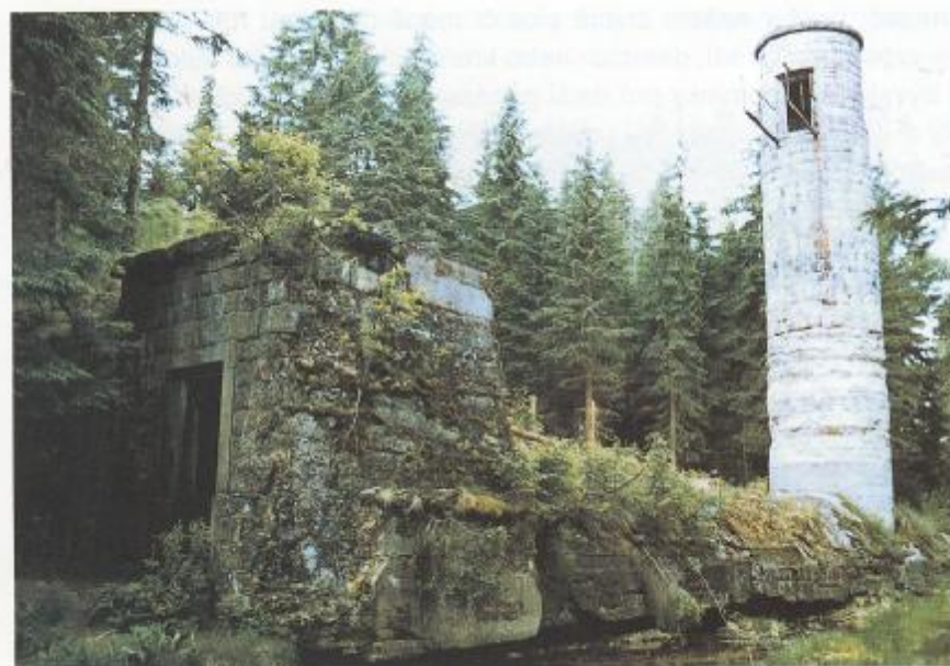
Výpustná štola na vzdušné straně a šoupátková šachta
