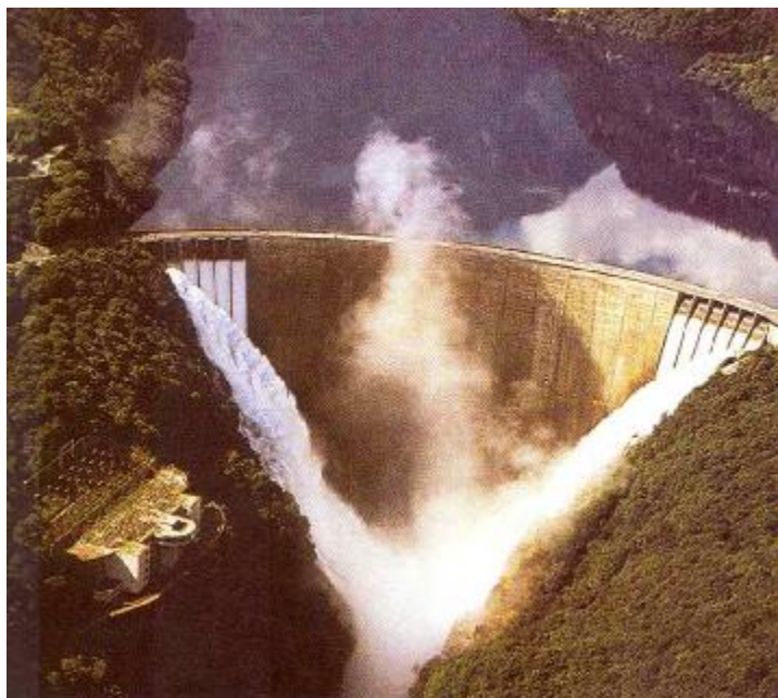
Švýcarsko - Contra Betónová klenbová přehrada.
