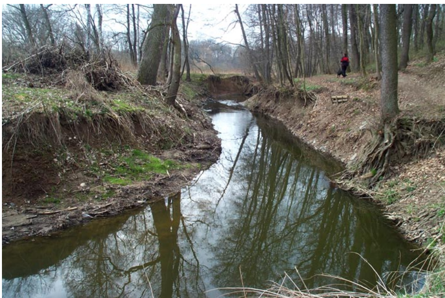
Eroze břehů Botiče v úseku nad Hostivařskou přehradou. Eroze je způsobena zaústěním dešťové kanalizace Petrovic. Zdroj: Vlastní
