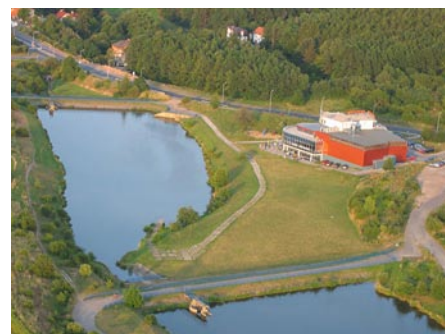
Dešťové retenční nádrže je možné realizovat i s ohledem na prostředí, do něhož jsou umístěny, jak ukazuje příklad dvou retenčních nádrží se stálým nadřzením na Košíkovském potoce (povodí 300 ha) o objemu 2 x 15 tisíc m 3 . Zdroj: SB Centrum, s. r. o.
