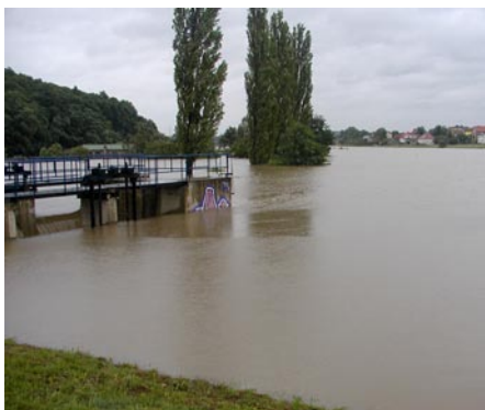
Suchý poldr Čihadla naplněný při průchodu cca třicetileté povodně na vodním toku Rokytka VIII v roce 2002. Zdroj: Vlastní
