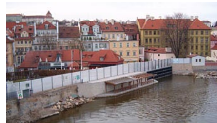
Etapa 0002: Ústí Čertovky s uzavřenými vraty a postaveným mobilním hrazením. Zdroj: Cabrnach, 2007
