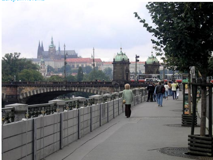
Protipovodňovou ochranu města zajišťují v centru převážně mobilní stěny. Zdroj: Jiří Hovorka
