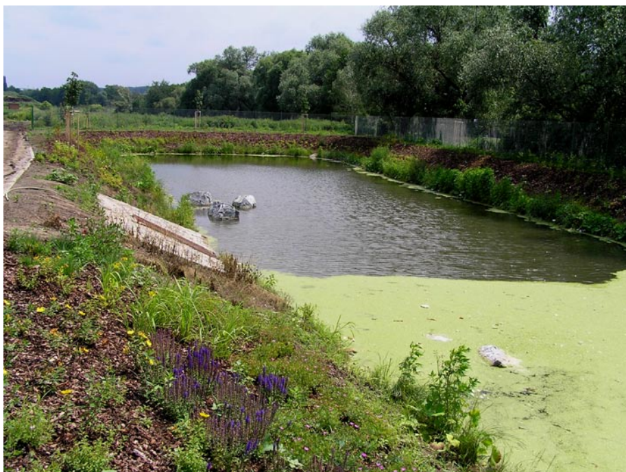
Retenční nádrž Zahradní Město s hladinou stálého nadržení s přírodními břehy. Zdroj: Vlastní
