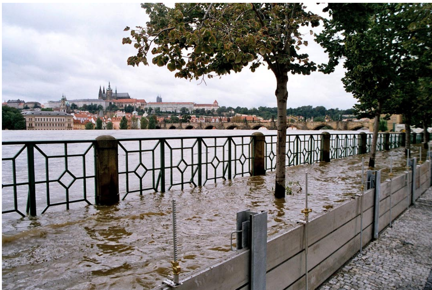
Kulminace povodně 14. srpna 2002 na Smetanově nábřeží: Staré Město zachránila před zatopením mobilní protipovodňová bariéra.
