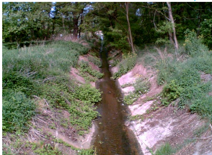
Regulace Cholupického potoka betonovým opevněním. Zdroj: Vlastní
