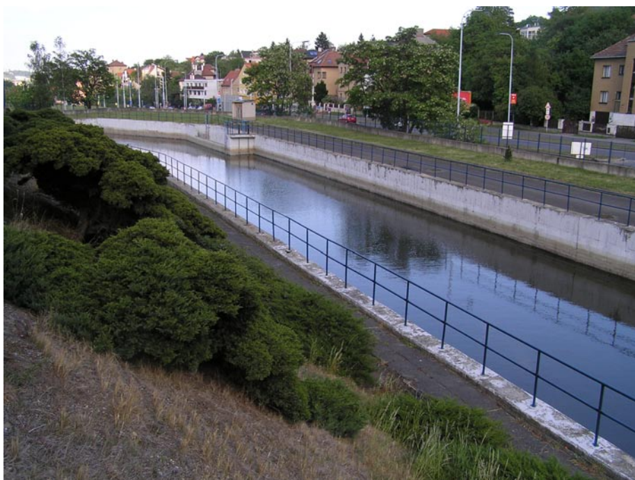
Retenční nádrž Řepy II s hladinou stálého nadržení se svislými betonovými zdmi. Zdroj: Vlastní
