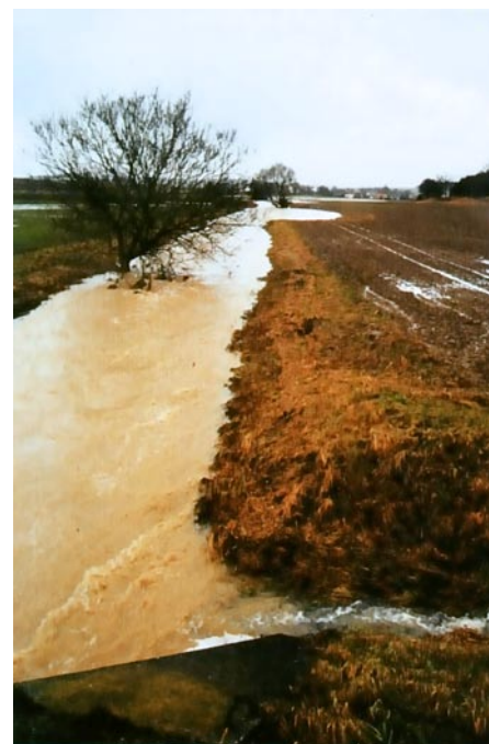
Tento potok byl zregulován (jakož i řada dalších) v důsledku scelování polí v 50. a 60. letech 20. století. I při vysokém průtoku vody nevystupuje z břehů a odvádí vodu velkou rychlostí ihned do nejbližší řeky, jež tak dosahuje během krátké doby vysokých odtokových maxim. Zdroj: Spektrum Wasser 1, 2004
