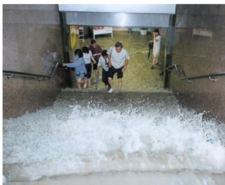
Podzemní nákupní centrum ve Fukuocce, Japonsko, zatopené přivalovým deštěm v roce 1999. Zdroj: Japan Sewage Works Association
