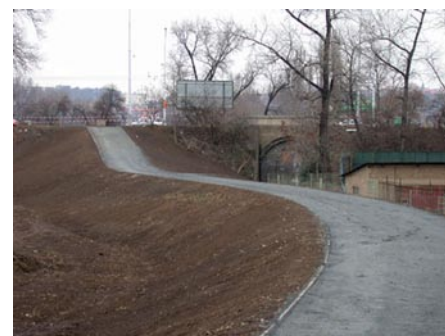
Etapa 0003: Zemní hráz na Rohanském ostrově. Zdroj: Cabrnach, 2007
