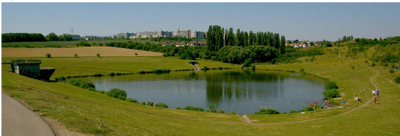
Retenční nádrž Stodůlky III, pravý břeh. Zdroj: Vlastní
