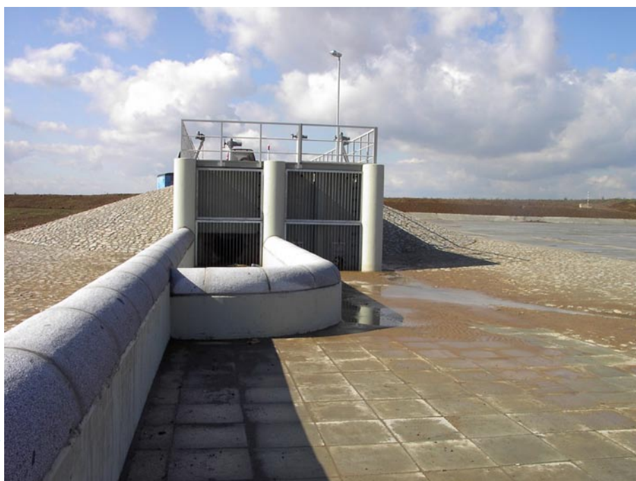
Diskutabilní řešení – dešťová nádrž v průmyslové zóně Černovická terasa (povodí 200 ha) o objemu 100 tisíc m 3 , která zároveň slouží k zachycení stoleté povodně v Ivančickém potoce. Zdroj: Aqua Procon, s. r. o.
