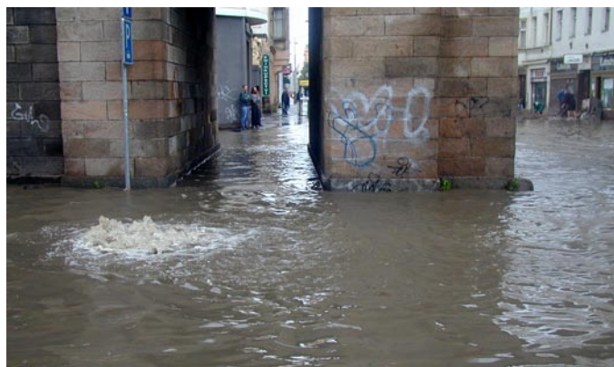
Výron vody z Vltavy kanalizační sítí při povodni v roce 2002 v ulici Sokolovská, Praha-Karlín. Zpětné vzduť způsobuje záplavu intravilánu, který v daném okamžiku není přímo ohrožen povodňovým stavem v toku. Zdroj: Archiv PVS, a. s.
