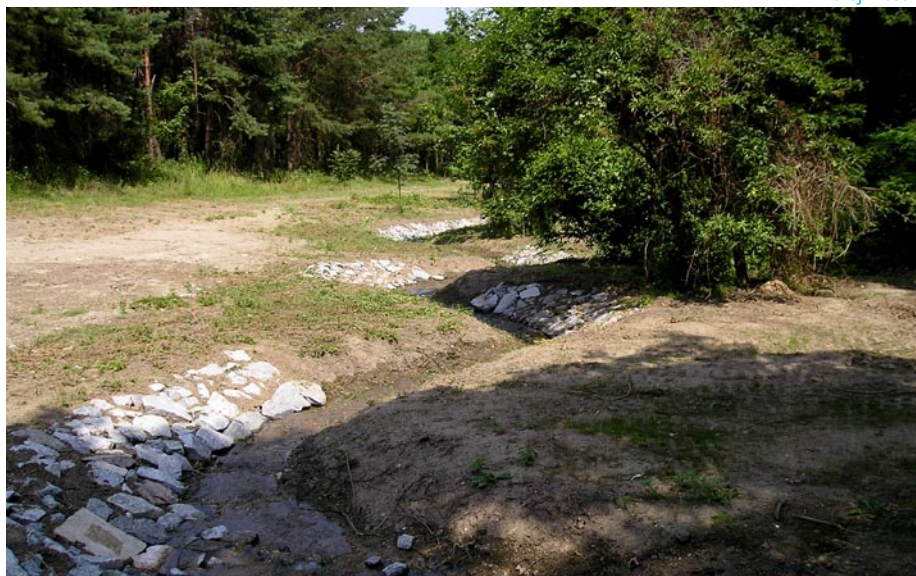
Revitalizované koryto Krůteckého potoka krátce po dokončení prací (červenec 2007). Zdroj: Vlastní
