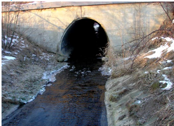
Betonový propustek na Pražském okruhu, lokalita potoka Chvalka. Zdroj: Vlastní
